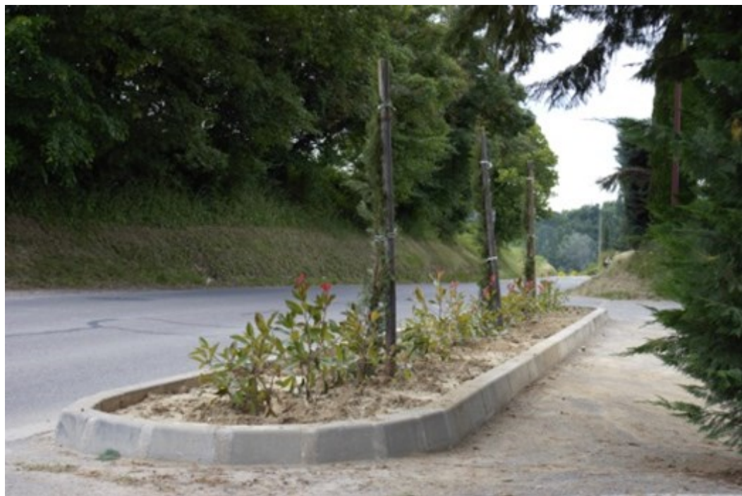
Du 2 au 6 juin 2020 : Nouvelle entrée de parking
